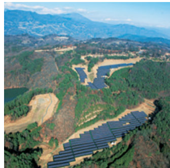
川中嶋太陽光発電所
