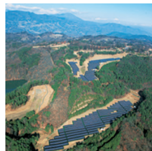
川中嶋太陽光発電所
